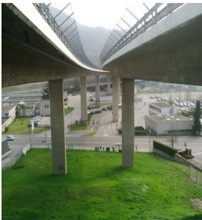
Fig.1 – Viadotto delle Fornaci (Svizzera)
